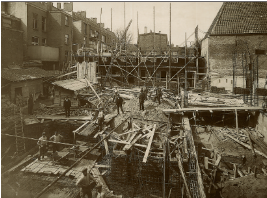
Bouwput bij de eerste fase van de nieuwbouw van de Centrale Bibliotheek aan de Bilderdijkstraat, 1922.
